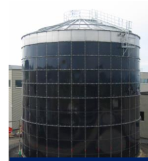
Silo- und Tankbau
